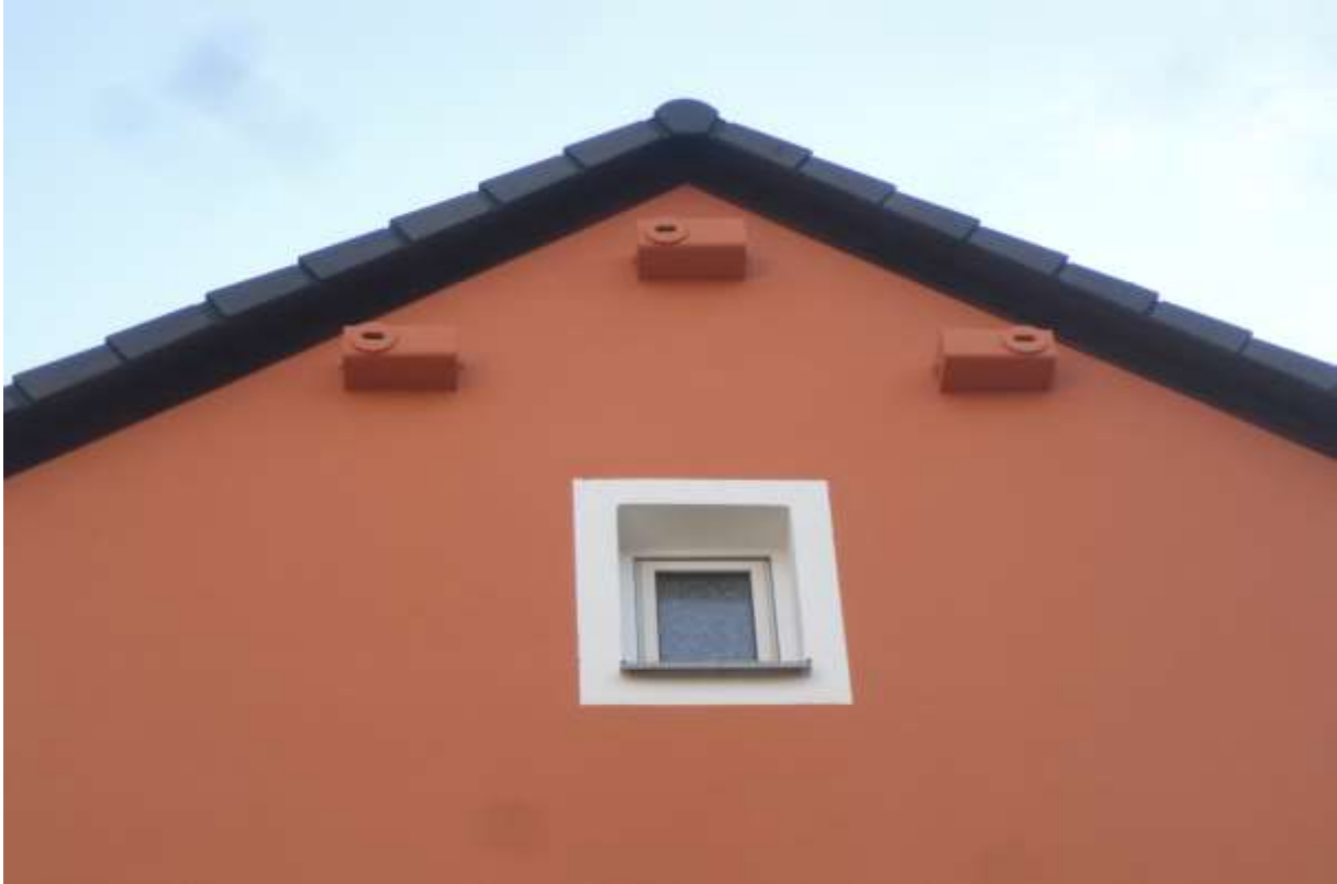
Abb. 2: Drei Mauerseglerkästen 17B am Wohngebäude Nörenbergstraße 53.
