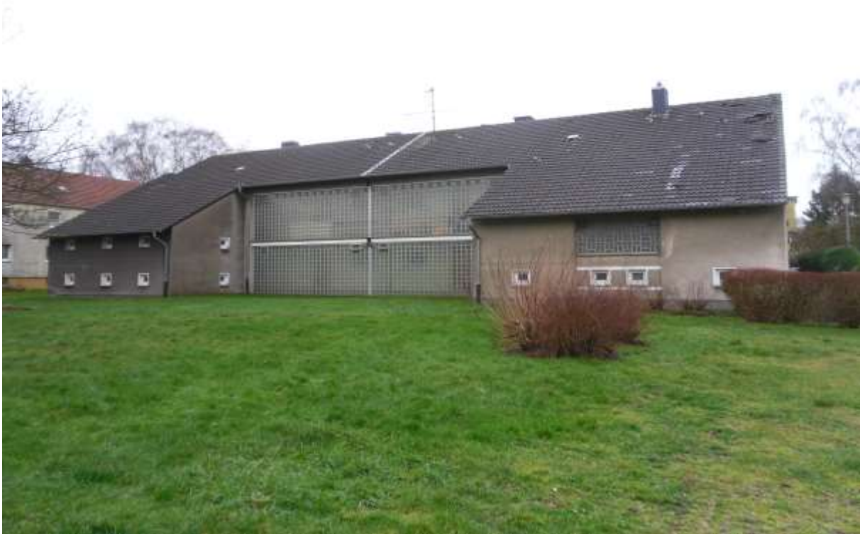
Abb. 1: Wohngebäude Rutgerweg 29 im Nörenberger Feld.
