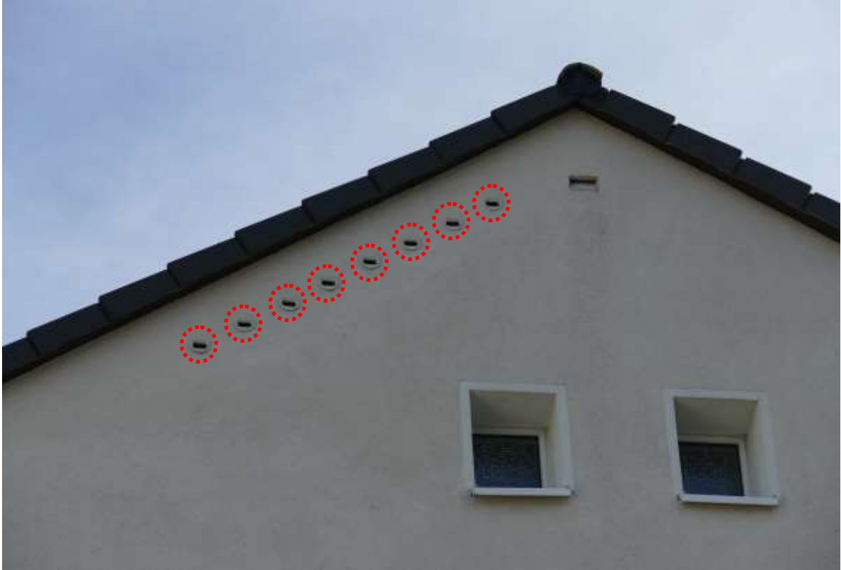
Abb. 7: Acht Mauerseglerkästen WDV 1A von Schwegler am Wohngebäude Wiesenstraße 18.
