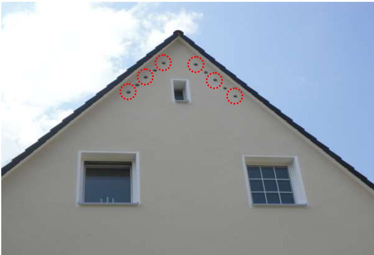
Abb. 16: Zehn fassadenintegrierte Mauerseglerkästen WDV 1A am Gebäude Brinkhofstraße 19.
