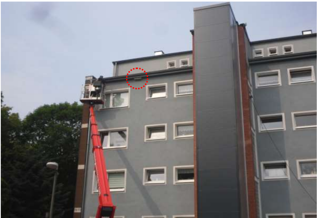
Abb. 22: Fertiger Aufzugschacht und Anbringung der Ersatznisthilfen.
