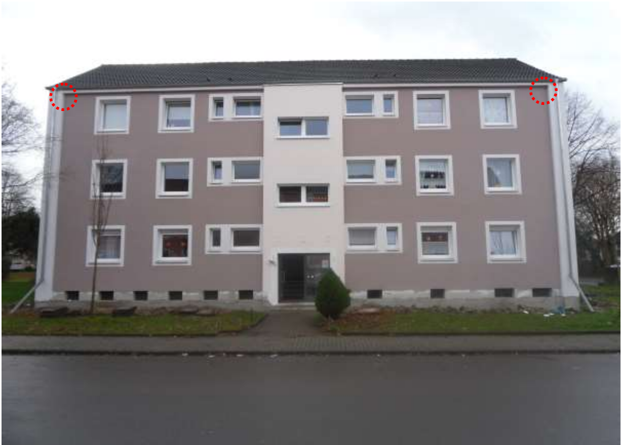
Abb. 3: Das sanierte Gebäude Barbarastraße 3 mit zwei Mauerseglernisthilfen Nr. 17 von Schwegler.
