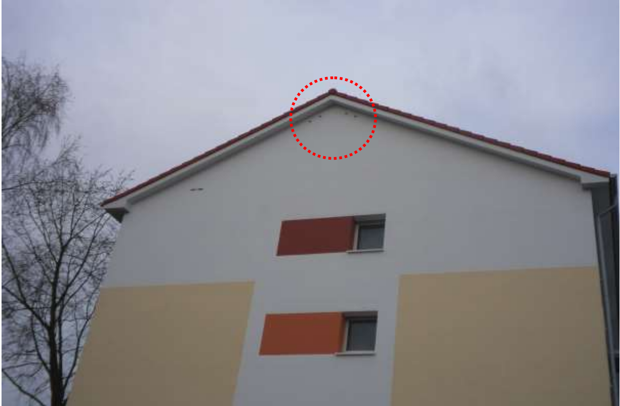
Abb. 24: Vier fassadenintegrierte Mauerseglerkästen in engen Abstand verbaut.
