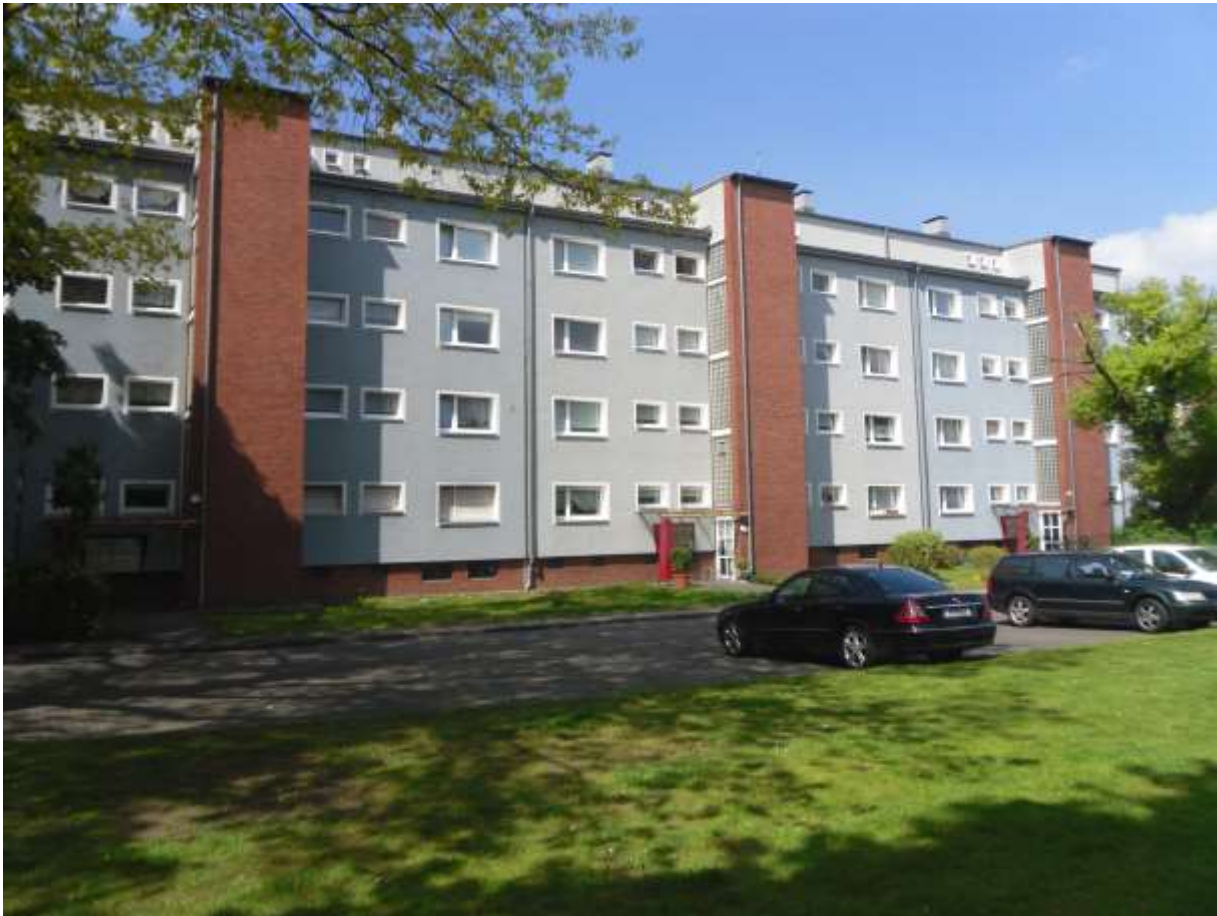
Abb. 20: Ausgangssituation an der Kampstraße in Marl vor dem Anbau der Aufzugschächte.
