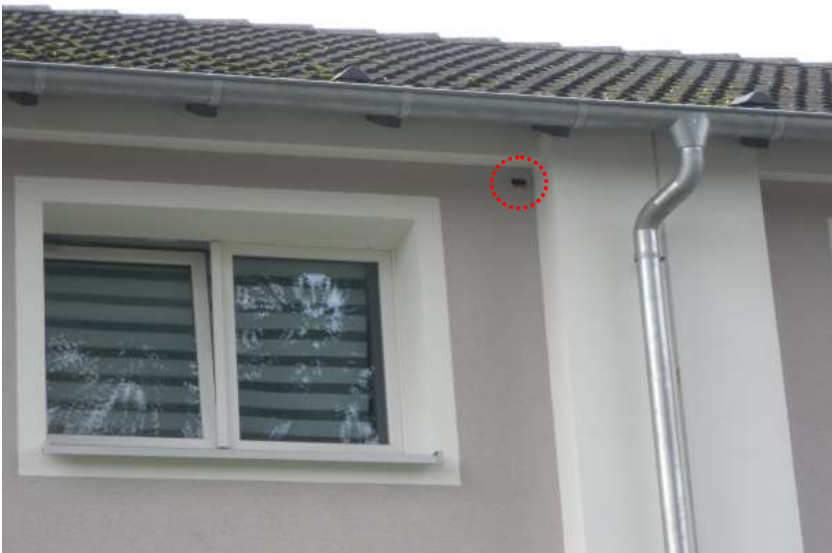
Abb. 4: Das sanierte Gebäude Steinstraße 71 mit einem Mauerseglerkasten WDV 1A von Schwegler.
