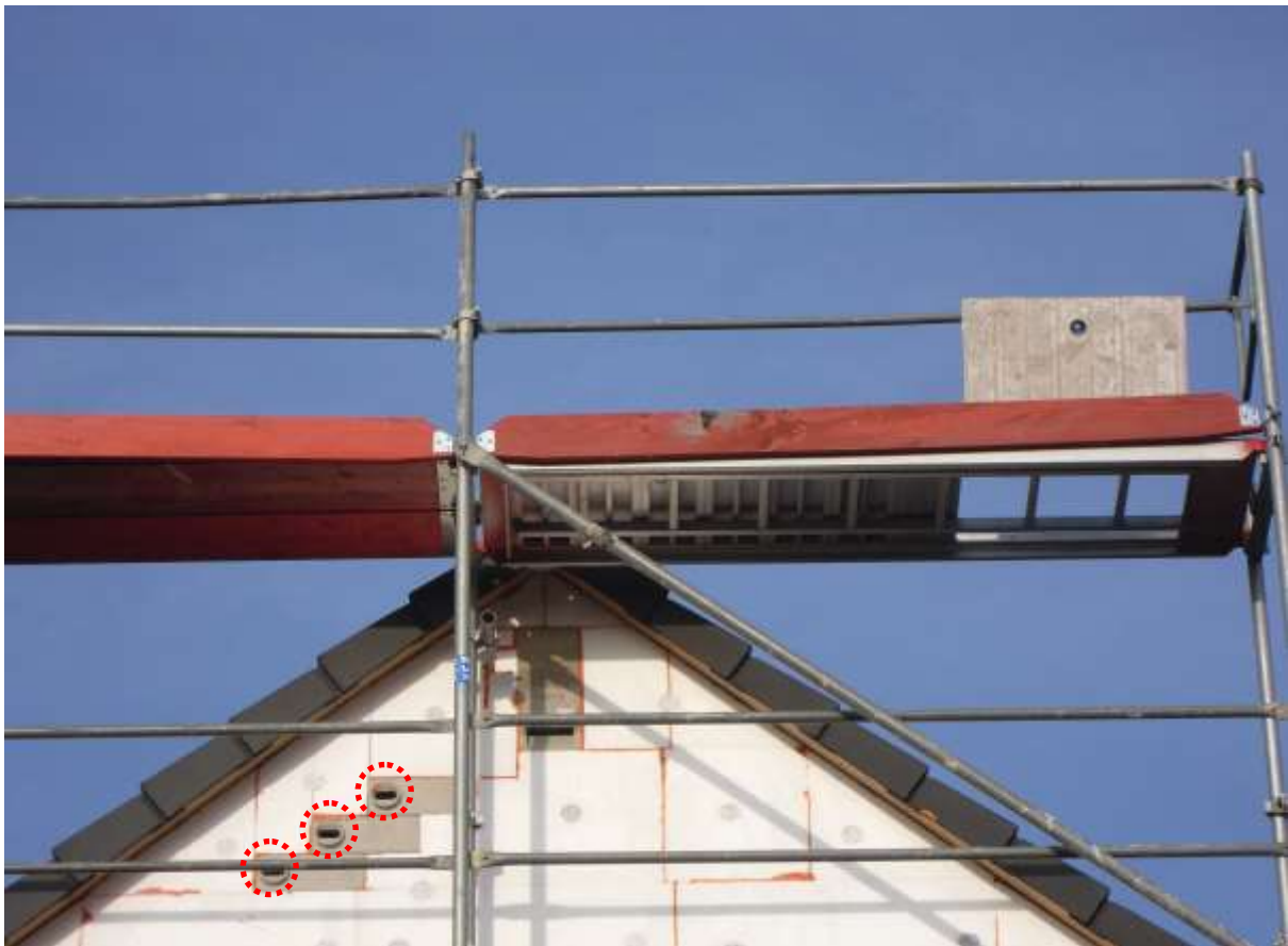
Abb. 9: Giebel Buschstr. 37 mit drei Mauerseglerkästen und einem Fledermausquartier (ohne Putz).
