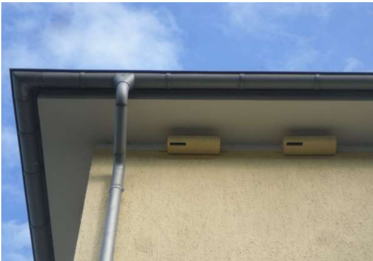
Abb. 19: Mauerseglerkästen TC 2 an einem Wohngebäude in Hagen.
