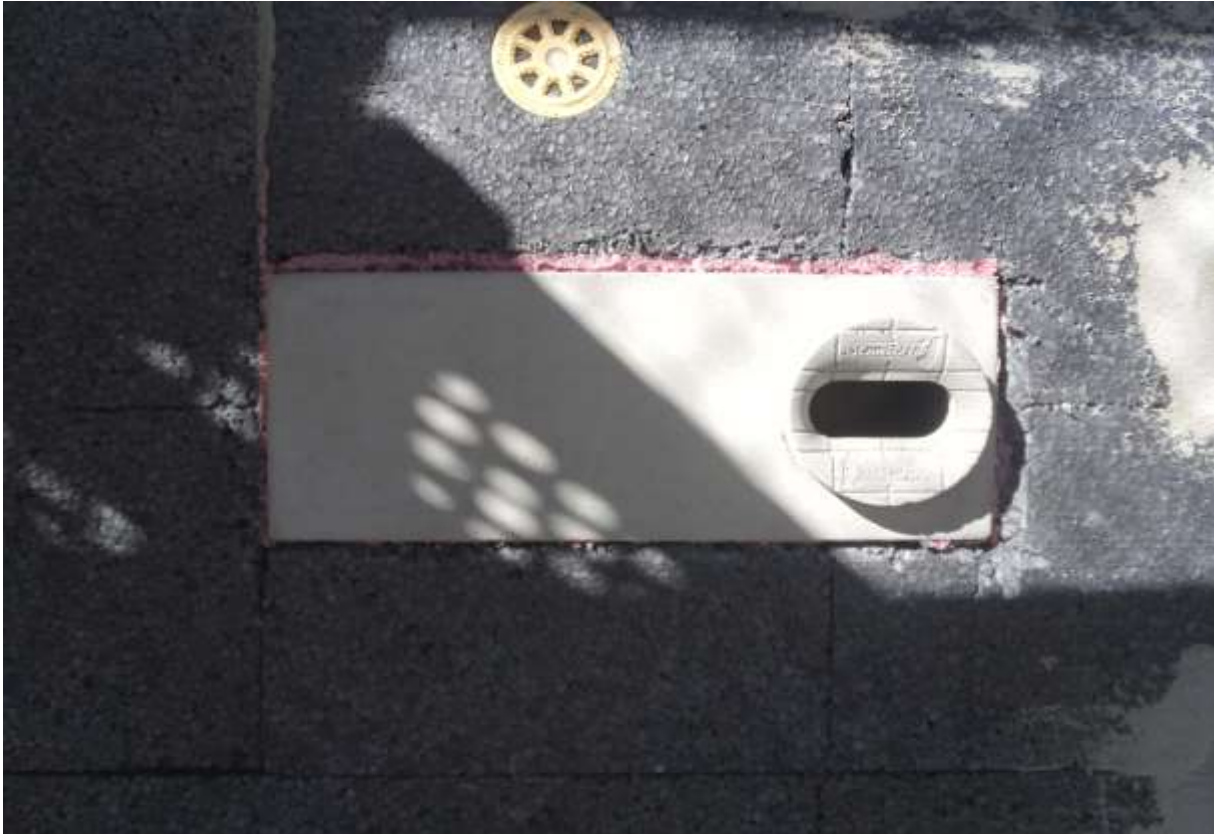
Abb. 15: Fassadenintegrierter Mauerseglerkasten WDV 1A der Firma Schwegler.
